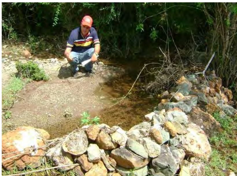
Figura 6. Tranques de piedra para evitar la erosión
