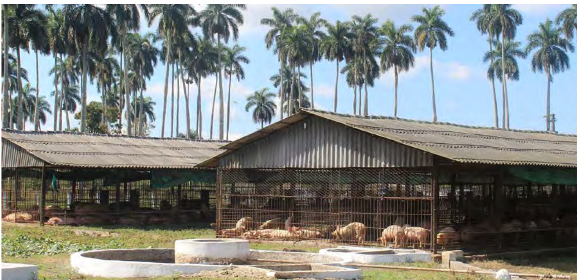
Figura 1. Biodigestor instalado por el Proyecto BIOMAS-Cuba
